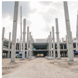
เสาและคานคอนกรีตสำเร็จรูป
