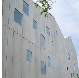
ผนังคอนกรีตสำเร็จรูป hollow core
